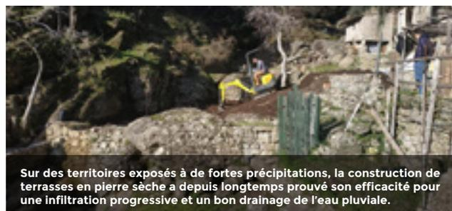
Sur des territoires exposés à de fortes précipitations, la construction de terrasses en pierre sèche a depuis longtemps prouvé son efficacité pour une infiltration progressive et un bon drainage de l'eau pluviale.
