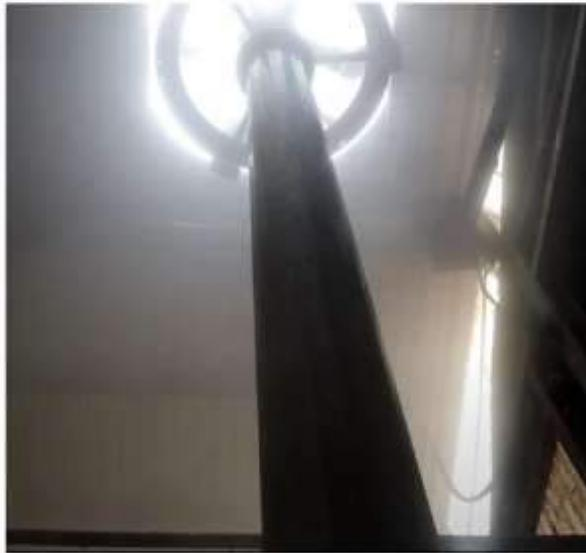
L'**HelixAir** est un **système de renouvellement d'air** conçu spécifiquement pour les bâtiments industriels devant **gérer des problématiques d'odeurs**. Son objectif principal est d'extraire l'air vicié de ces espaces et de le remplacer par de l'air frais de l'extérieur.
